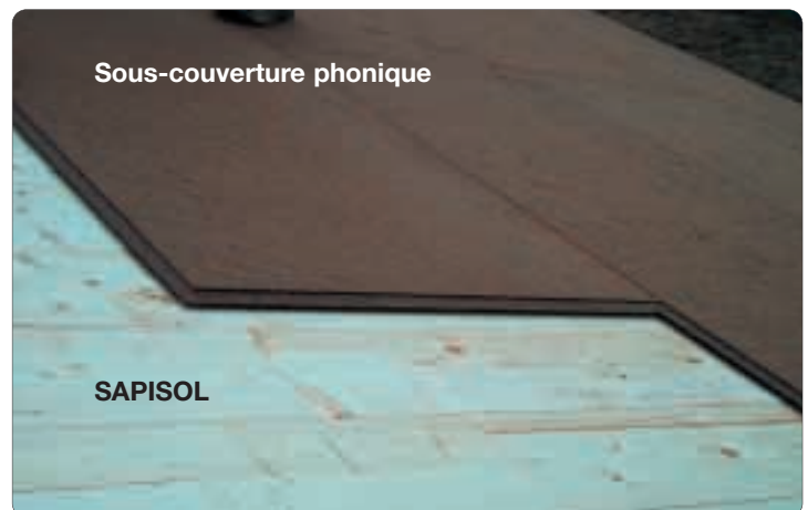
La sous-couverture phonique remplace le film pare-pluie
