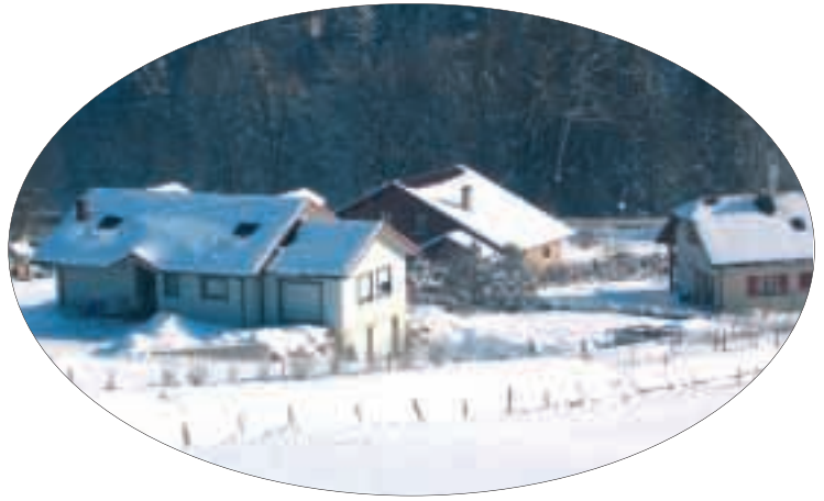
Avant l'arrivée du soleil, la neige ne fond pas au faîtage sur une toiture SAPISOL
